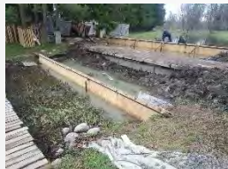
Выполнение работ по ремонту плотин у островка на Верхних прудках в Екатерининском парке
