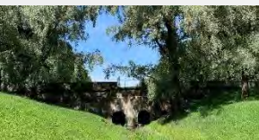
Ремонт моста-плотины (Виттолова моста) в Екатерининском парке
