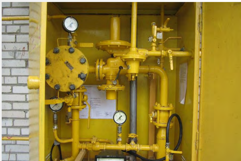
Шкафная газорегуляторная установка
