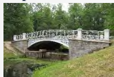
Ремонт и реставрация моста со шлюзом в Александровском парке
